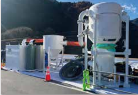
大型TYPE / 55kw 施工延長 300m
